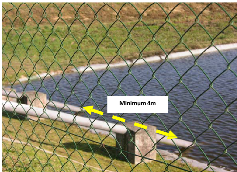
Deux colonnes de 150 mm, espacées entre elles d'au minimum 4m
